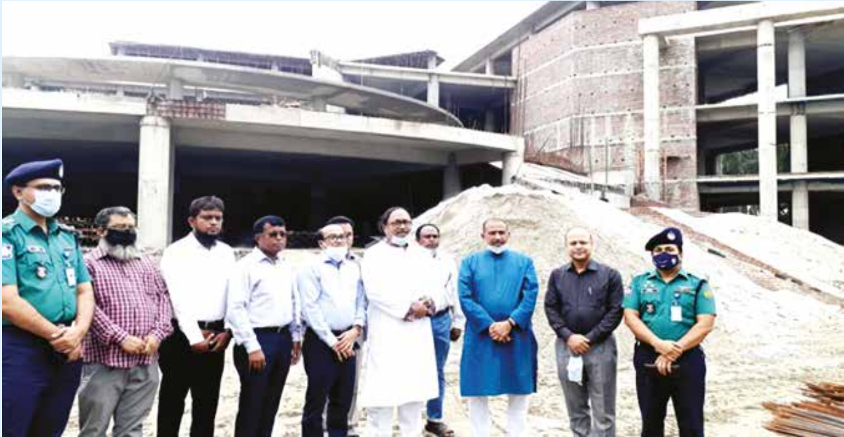
রাজশাহী নভোথিয়েটার স্থাপনের কাজ পরিদর্শন করছেন মাননীয় মন্ত্রী স্থপতি ইয়াফেস ওসমান
